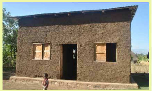
ምስል 14: አይሮች ወደ ውስጥ እንዳይገቡ ለሚከላከል የታችኛው ክፍል በኮንክሪት የተሰራ እና የንፁህ ቤቶች ምሳሌ የሚሆን
