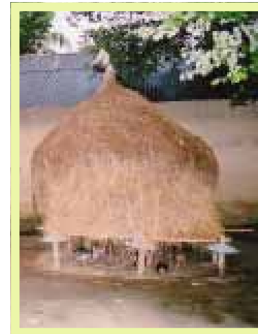
Fakkii 17 Fakkeenya baaxxee naannoftuu utubaawwanii kan hantuuttan ol koruu ittisu
